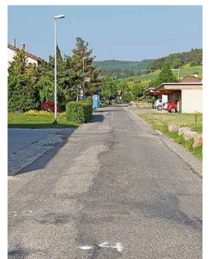
Die Poststrasse wurde oft repariert. CM
